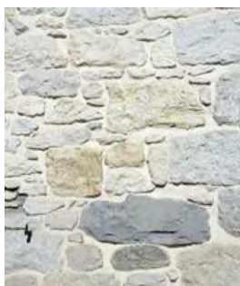
Moellons et pierres taillées à jointement
