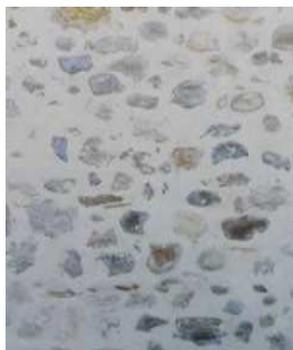
Galets et pierres tout venant recouverts d'enduit
