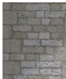
Moellons et pierres taillées à jointement
