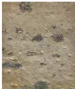
Galets et pierres tout venant recouverts d'enduit
